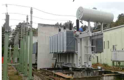
V času obnove so bili zamenjani trije energetske transformatorji
