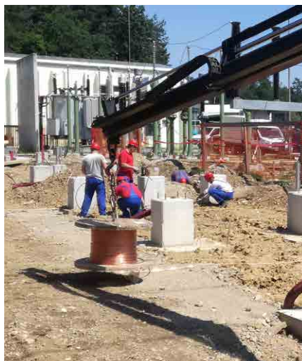
Sodelavci SE Maribor pri izvedbi ozemljitvene mreže RTP Dobrava
