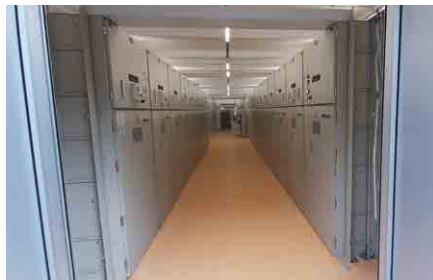
V 10 kV stikališču smo montirali 30 novih kovinsko odklopljenih izvlačljivih celic z vakuumskimi odklopniki
