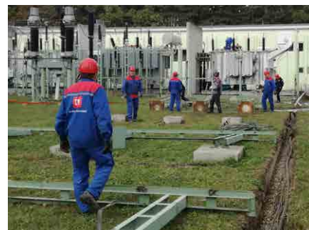
Sodelavci SE Maribor so izvedli vsa elektromontažna dela v 110 kV stikališču
