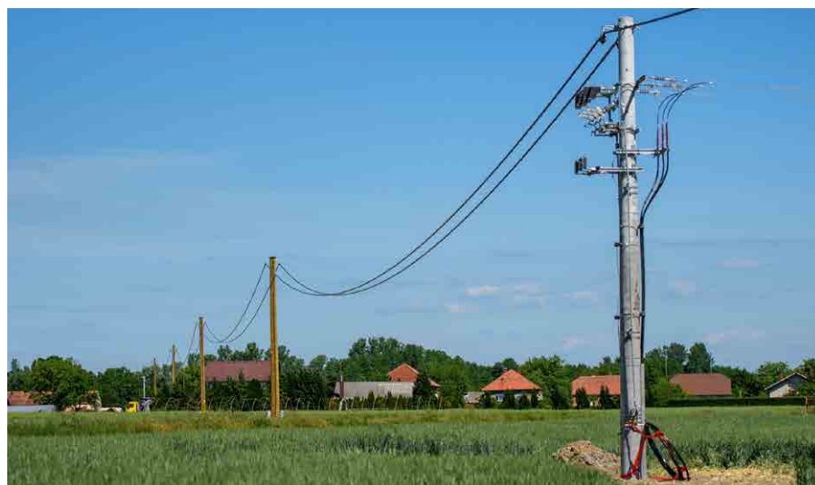
Obnova daljnovoda za zagotovitev kakovostnega napajanja
