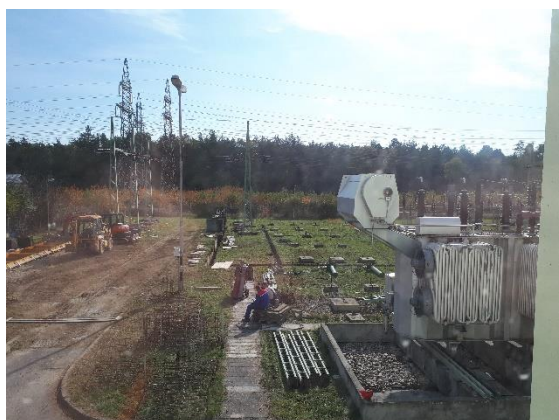
Slika 74: 110-kilovoltno stikališče RTP Dobrava
