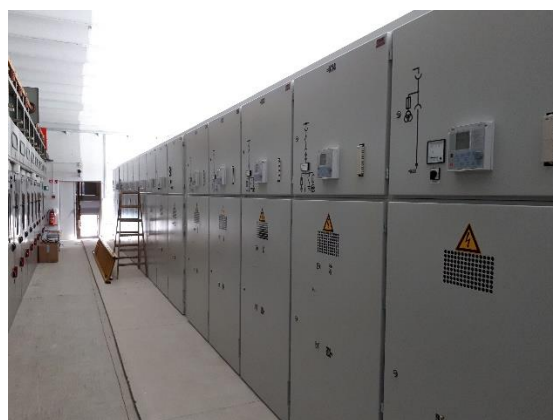
Slika 75: Novi del 10-kilovoltnih celic RTP Dobrava
