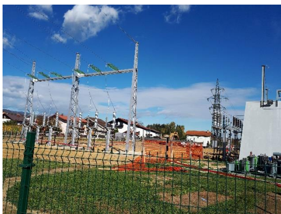
Slika 76: Nova 110-kilovoltna vključitev RTP Slovenska Bistrica
