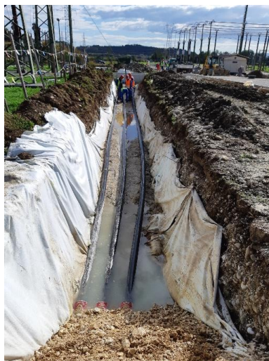
Slika 83: Polaganje kablov v RTP Podlog
