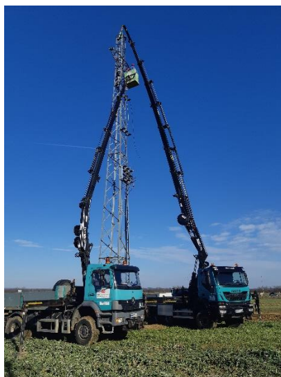
Slika 79: Demontaža jeklenih jamborjev čez avtocesto A5 (Pomurska avtocesta)
