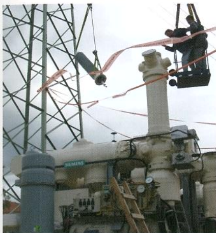
Montaža priključ. HIS za povezavo z DV 110 kV
