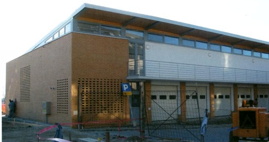
V zaključni fazi je izgradnja nadomestnega objekta operativno tehničnih služb.
