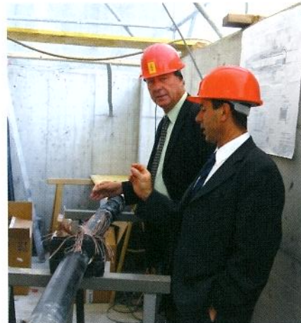
Izdelava kabskih glav 110 kV
