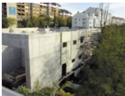
Skelet objekta: stikališče 110 in 20 kV s komando
