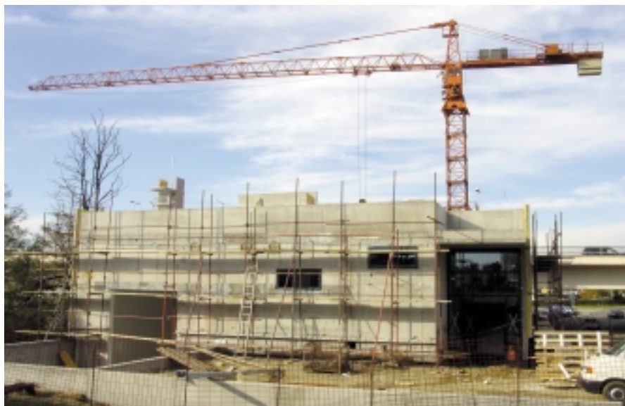
Pogled s Koroškega mostu
