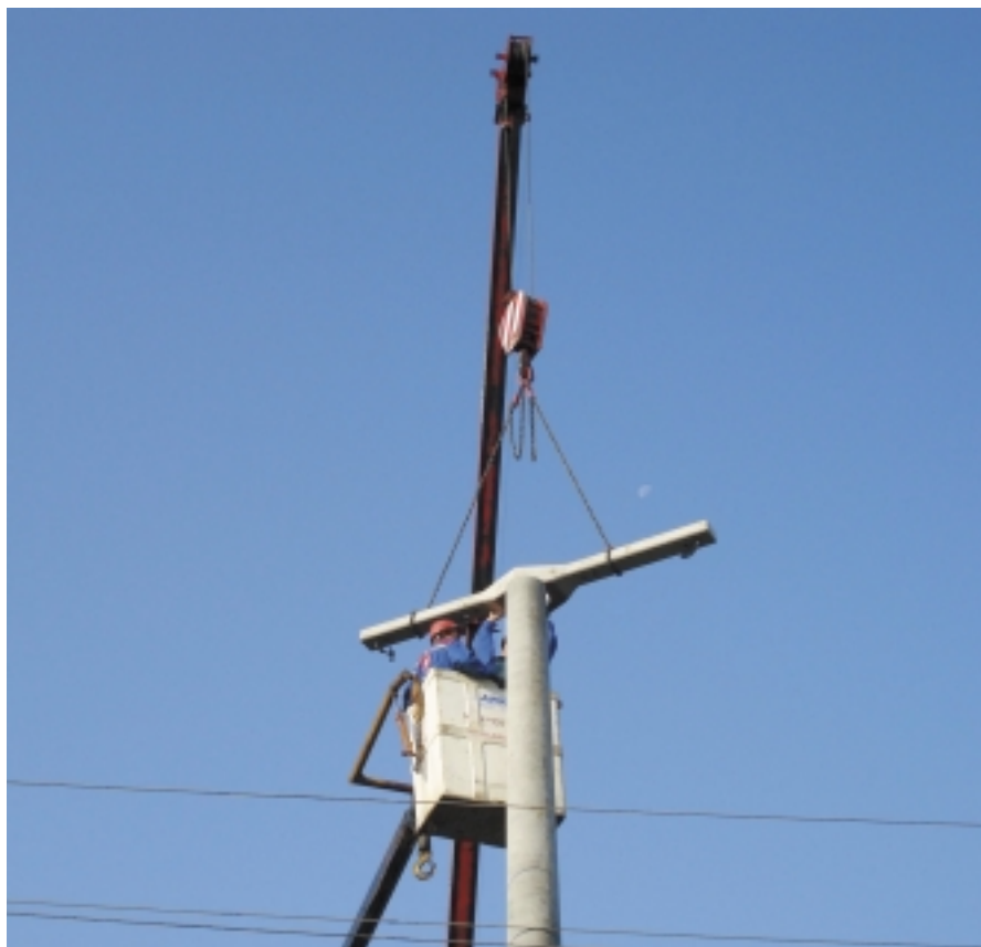
Montaža betonskega droga Z 12
