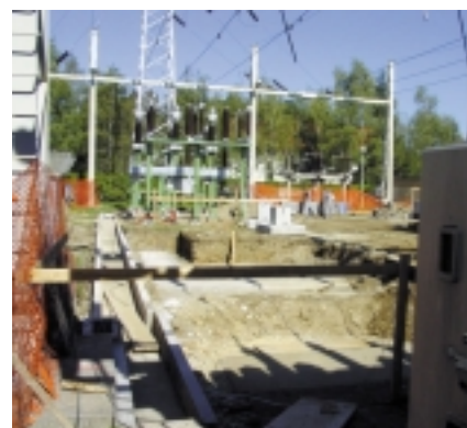
Obnova RTP Tezno
