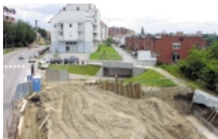
Priprava gradbišča razdelilno-transformatorske postaje: umik energetskih kablov 10 kV.
