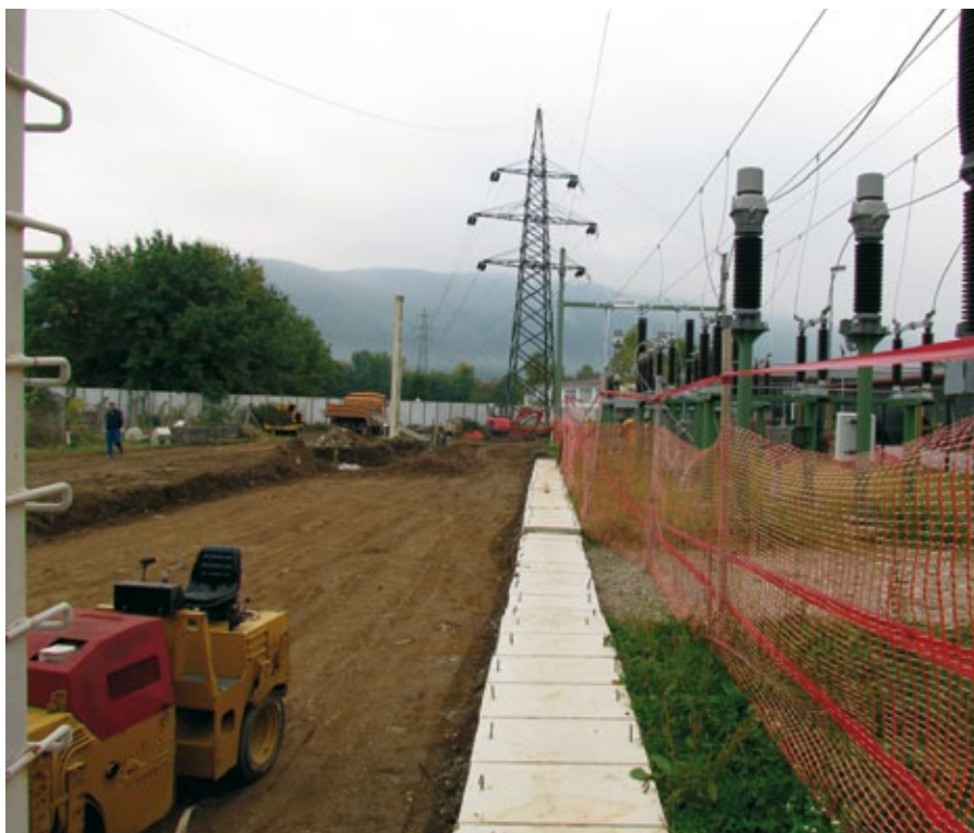
Levo začetek druge faze rekonstrukcije TR I in DV 110 kV Maribor IV, desno končana prva faza rekonstrukcije TR II in DV 110 kV Pekre III
