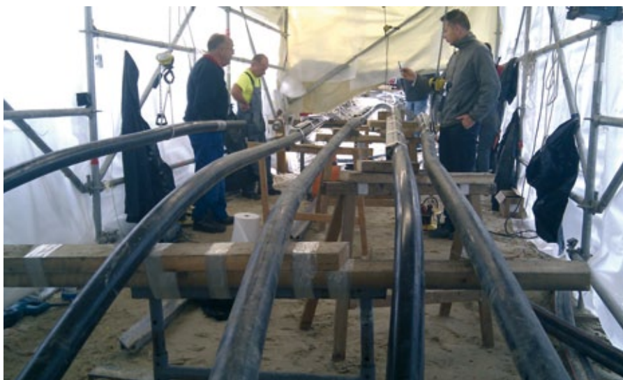
Izdelava kabelskih spoj št. 3 pod Koroškim mostom
