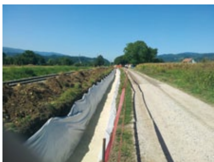
Odprti kabelski jarek na odseku 1 ob železnici
