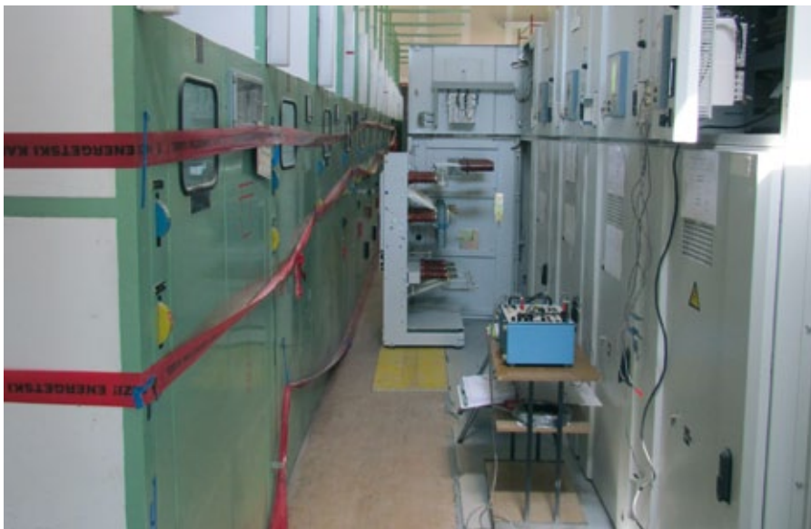
Prva faza rekonstrukcije RTP Radvanje 110/10 kV
