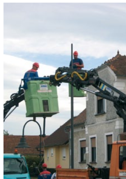
Izvajanje del na objektu izgradnje JR
