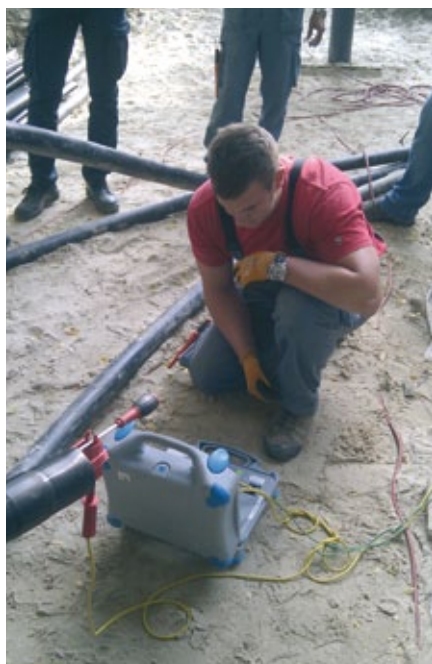
Sprotno testiranje kabla za ugotavljanje poškodb pri polaganju
