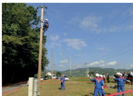
Pričetek dela pod napetostjo
