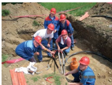
Skupina pri nameščanju kablovoda
