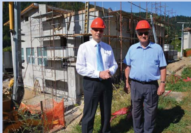
mag. Boris Sovič in g. Anton Kovše na ogledu gradbišča RTP Podvelka
