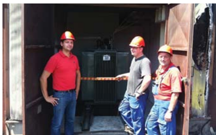
Del ekipe po končani sanaciji TP
