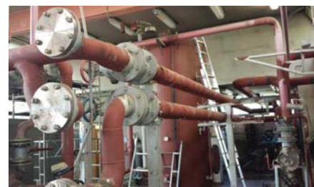
Obnovitvena dela kotlovnice
