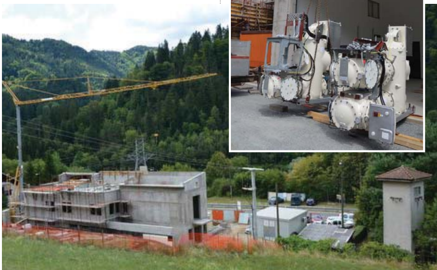
RTP Podvelka v izgradnji
