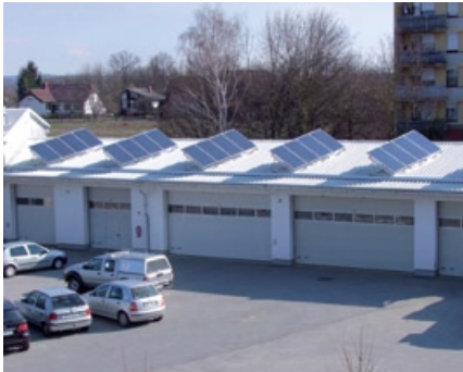
Slika 3: Sončna elektrarna OE Murska Sobota mFE – 25,2 kWp
