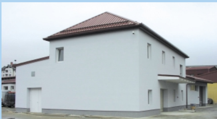
Delavnice po obnovi
