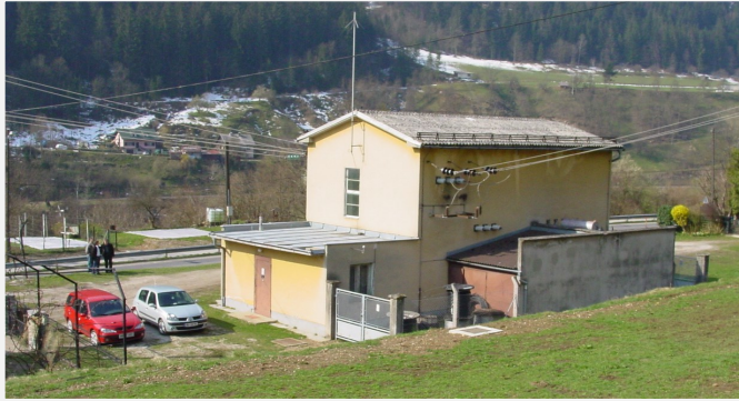
Stara razdelilna transformatorska postaja Podvelka
