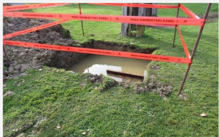
Blizu Zgornje Ščavnice, 15 km severovzhodno od Maribora, obnavljamo transformatorsko postajo.
