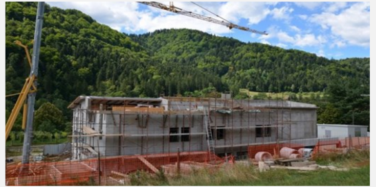
Gradnja nove razdelilno transformatorske postaje Podvelka
