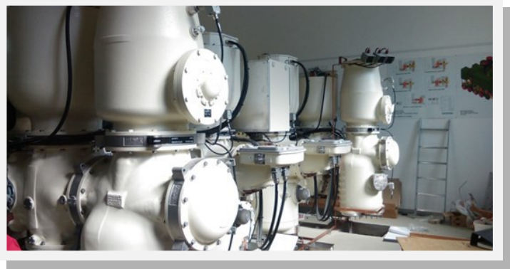
Najsodobnejše 110 kV plinsko izolirano stikališče
