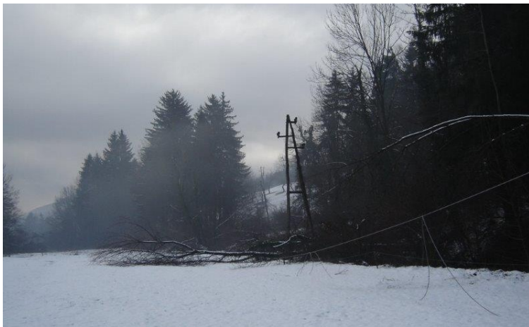
Daljnovod, ki ga je poškodoval februarski žled
