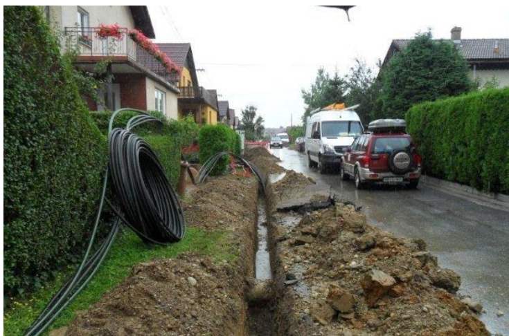
Priprava jarka za položitev kablovoda
