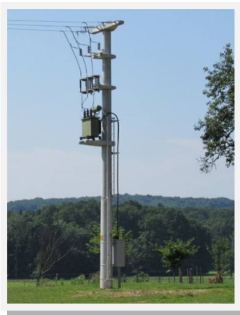
Obnovljena transformatorska postaja Foto: arhiv OE Gornja Radgona
