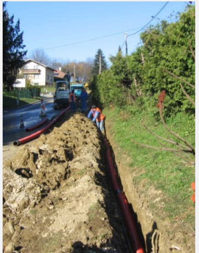
TP Malečnik, izkop trase za SN kablovod Foto.: arhiv OE Maribor z okolico
