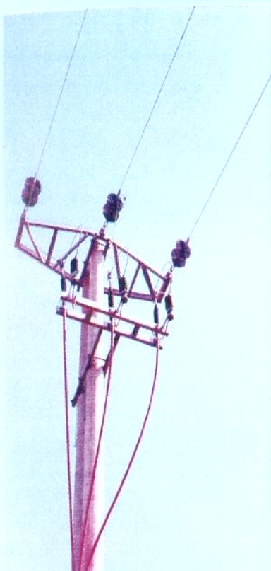
Рис. 1.1. Установки для монтажа
