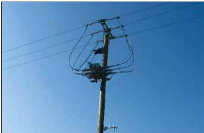
Slika 8a in b: Priprava in montaža daljinsko vodenega stikala
