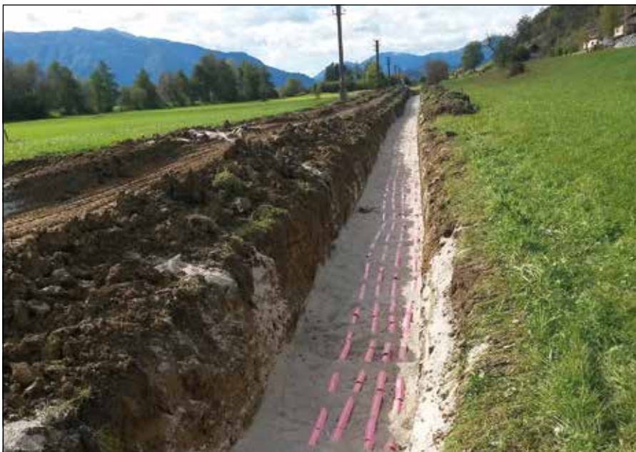
Slika 1: Usmeritve GIZ distribucije električne energije (prehod iz nadzemnih vodov v kabelsko izvedbo)
