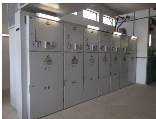
Slika 74: Rekonstrukcija RTP Murska Sobota – 20-kilovoltno stikališče
