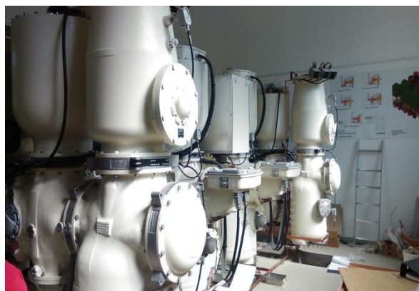
Najsodobnejše 110-kilovoltno plinsko izolirano stikališče
