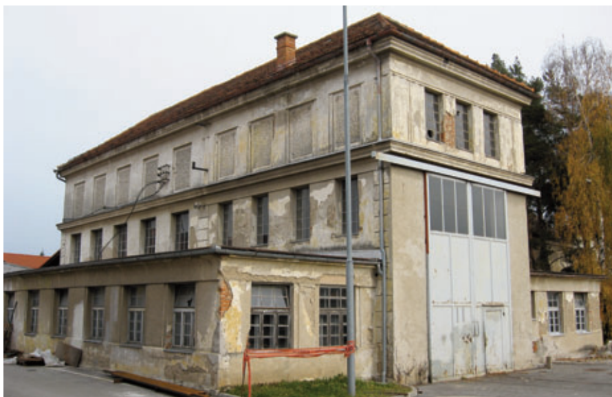
Transformatorska postaja v letu 2007
